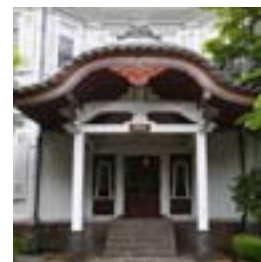
1906（明治39）年に建てられた西洋館。典型的な明治の西洋建築だが、玄関は唐破風の曲線のある屋根を持つ。
