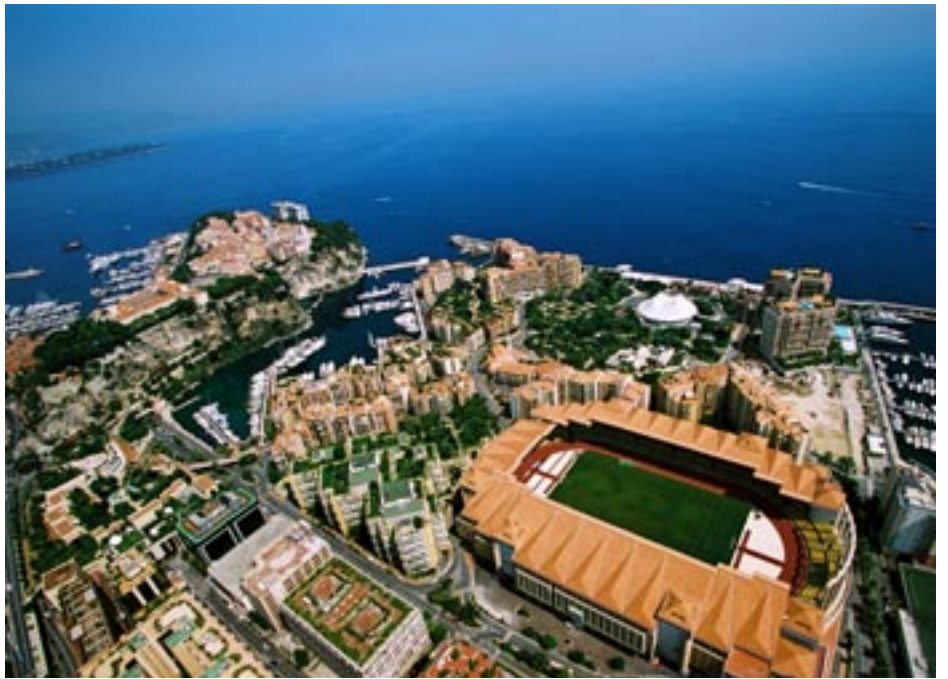
埋め立て工事により拡張されたフォンヴィエイユ地区
