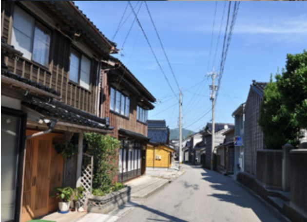
上 被災した黒島の町並み 下 修築され重建建地区に指定された黒島の町並み
