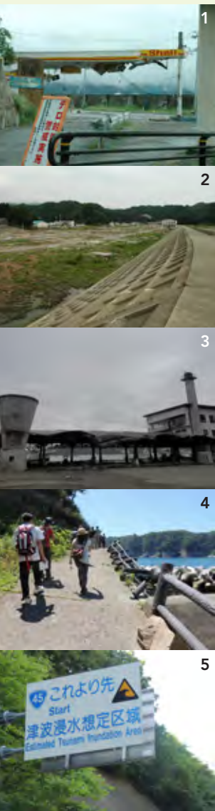
1 天井のみ残されたガソリンスタンド 2 壊滅した田老地区の住宅街。津波は「万里の長城」といわれた巨大堤防をも乗り越えた 3 宮古港(1、2、3は2011年8月撮影) 4 津波の被害を受けた三陸海岸沿いの遊歩道の手すり 5 「これより先 津波浸水想定区域」
